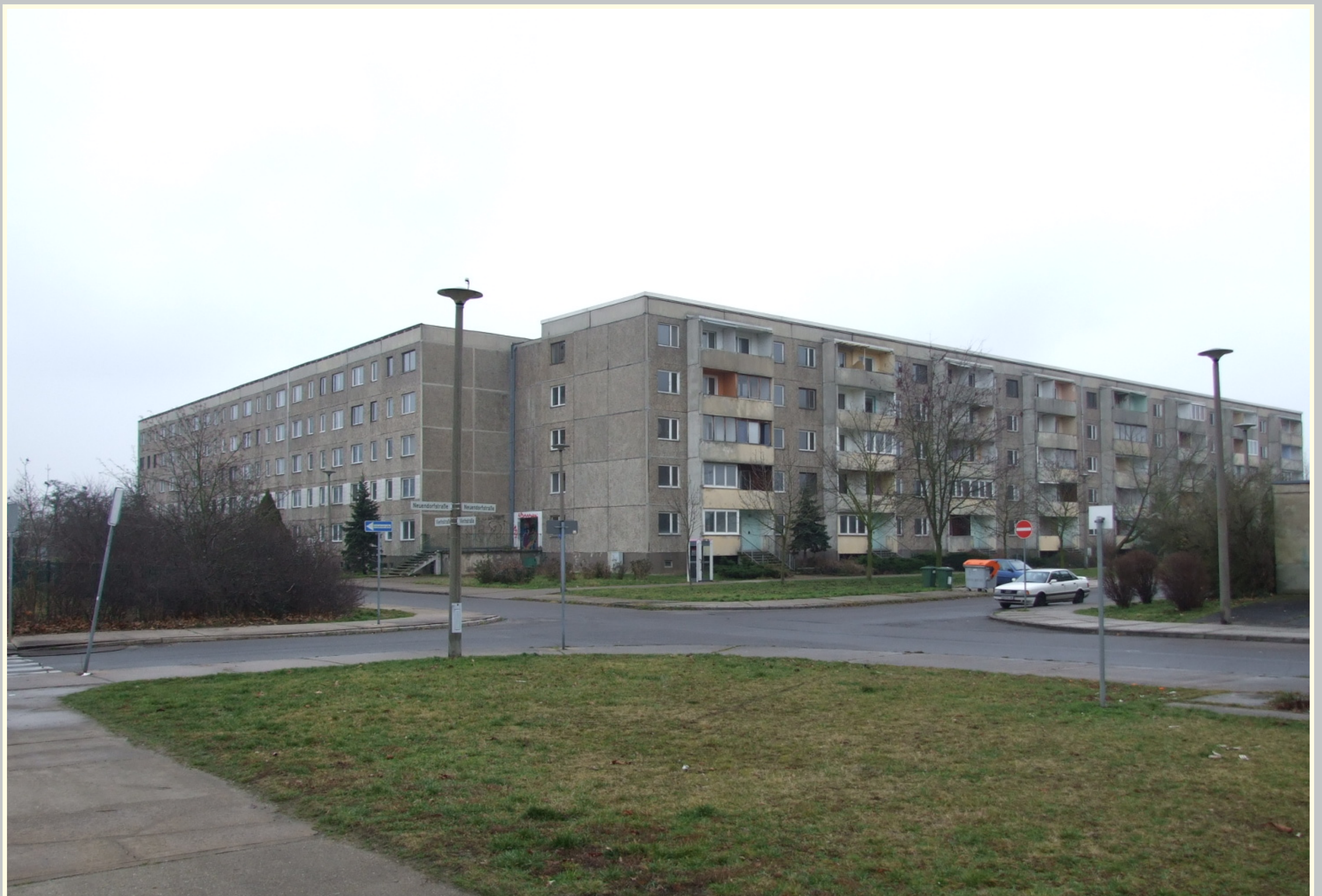
Viethstraße 22-32/ Neuendorfstraße 10-24, 2008 abgerissen, Foto: Stadt Dessau-Roßlau
