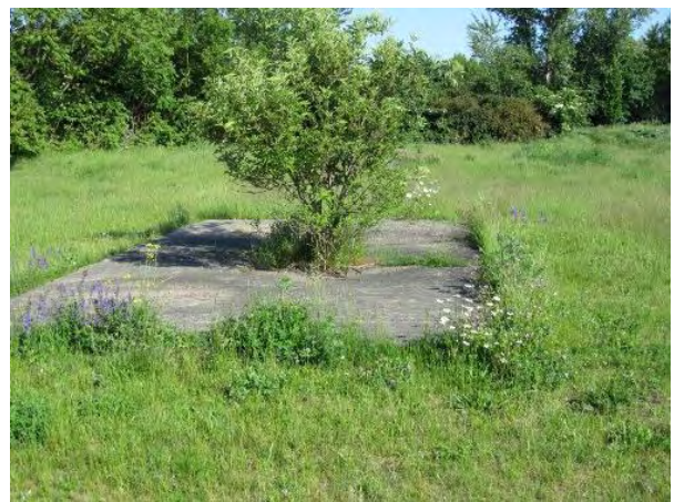
versiegelter Bereich im zentralen Teil der Teilfläche 4
