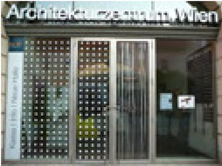
Abbildung 3: Mit Punktmuster markierte Glasfläche. (aus WUA 2014))
