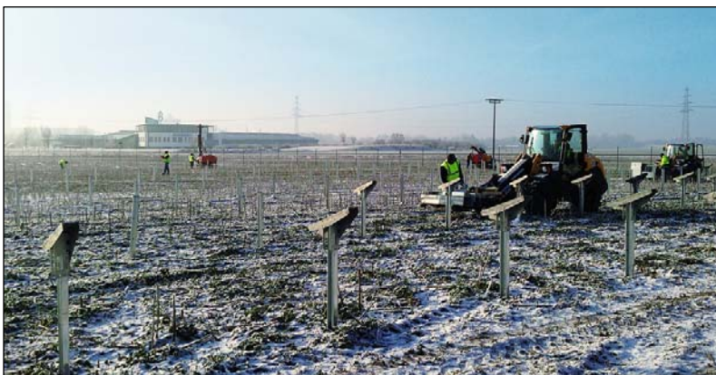
Abb. 11: Transport im Gebiet mittels Maschinen < 3,5 t
