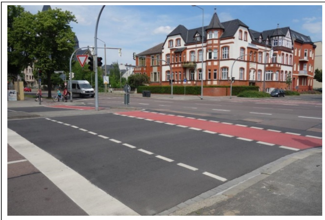
Radfurt an der Einmündung Humperdinckstraße/ Carl-Maria-von-Weber-Str. zur Albrechtstraße (Fahrbahnbelag und Markierung)
