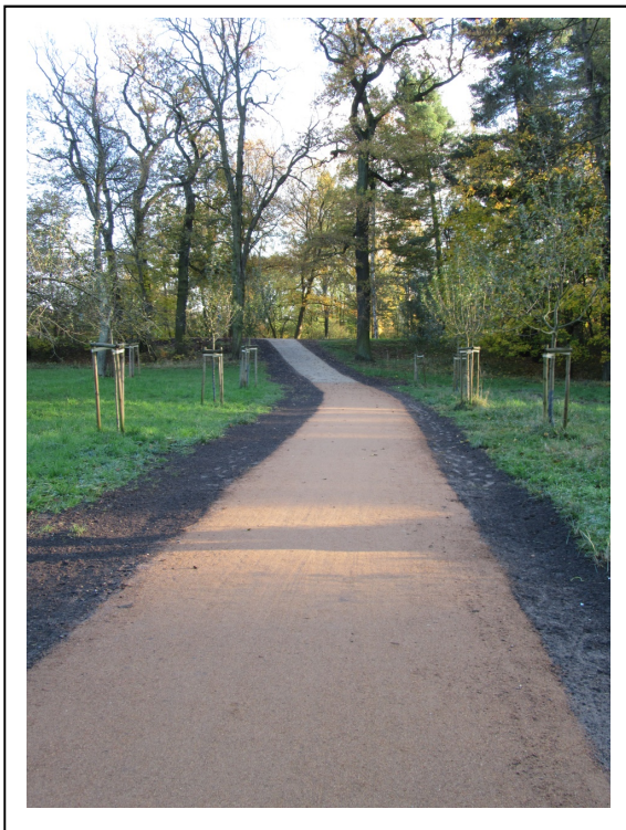
Ausbau Radweg im Kühnauer Park
