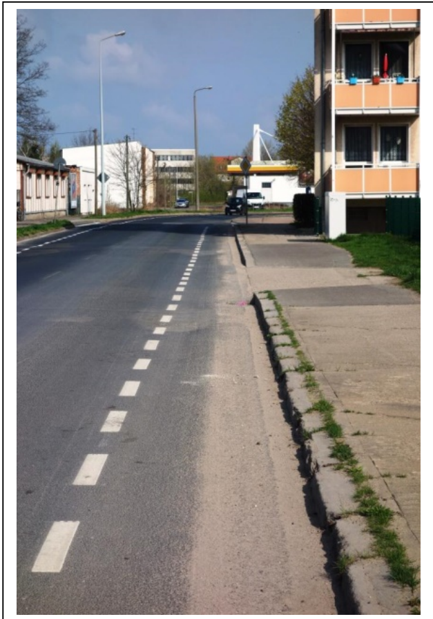
Anordnung von Schutzstreifen in der Raguhner Straße
