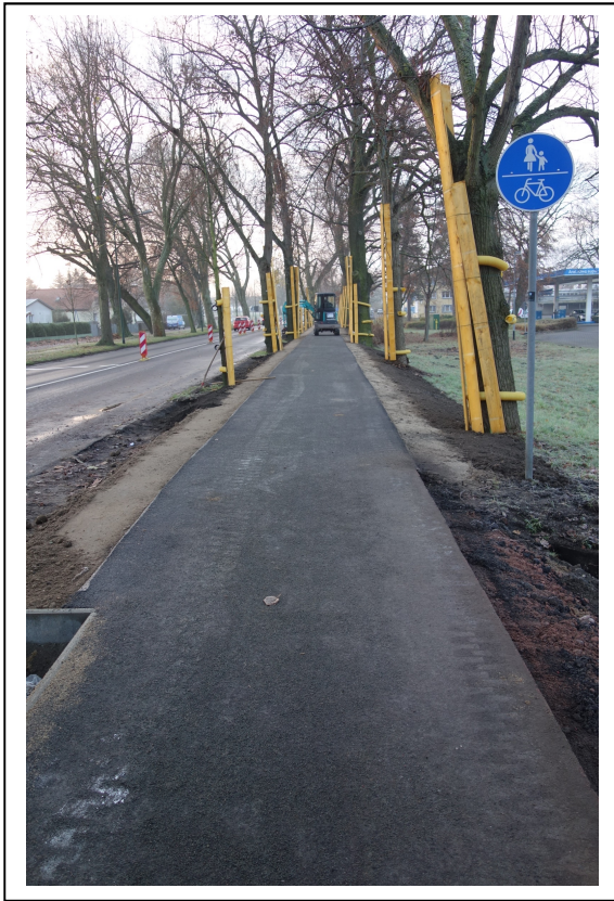
Ausbau Heidestraße, Bauphase
