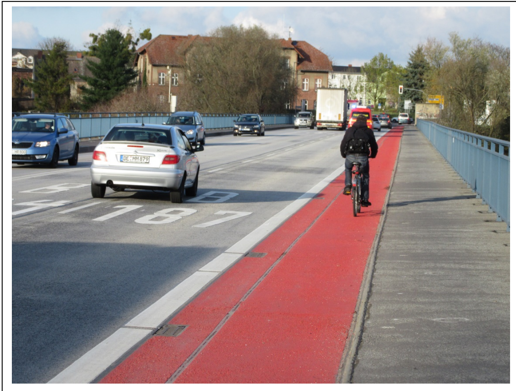
Verbreiterung Radfahrstreifen Elbebrücke
