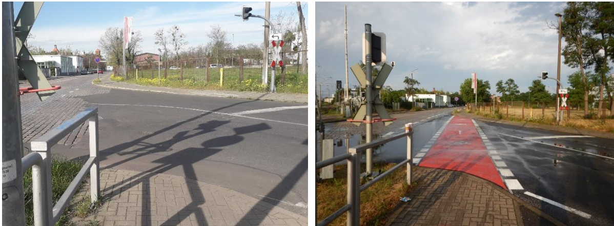
Einmündung Eisenbahnstraße vor und nach der Umgestaltung
