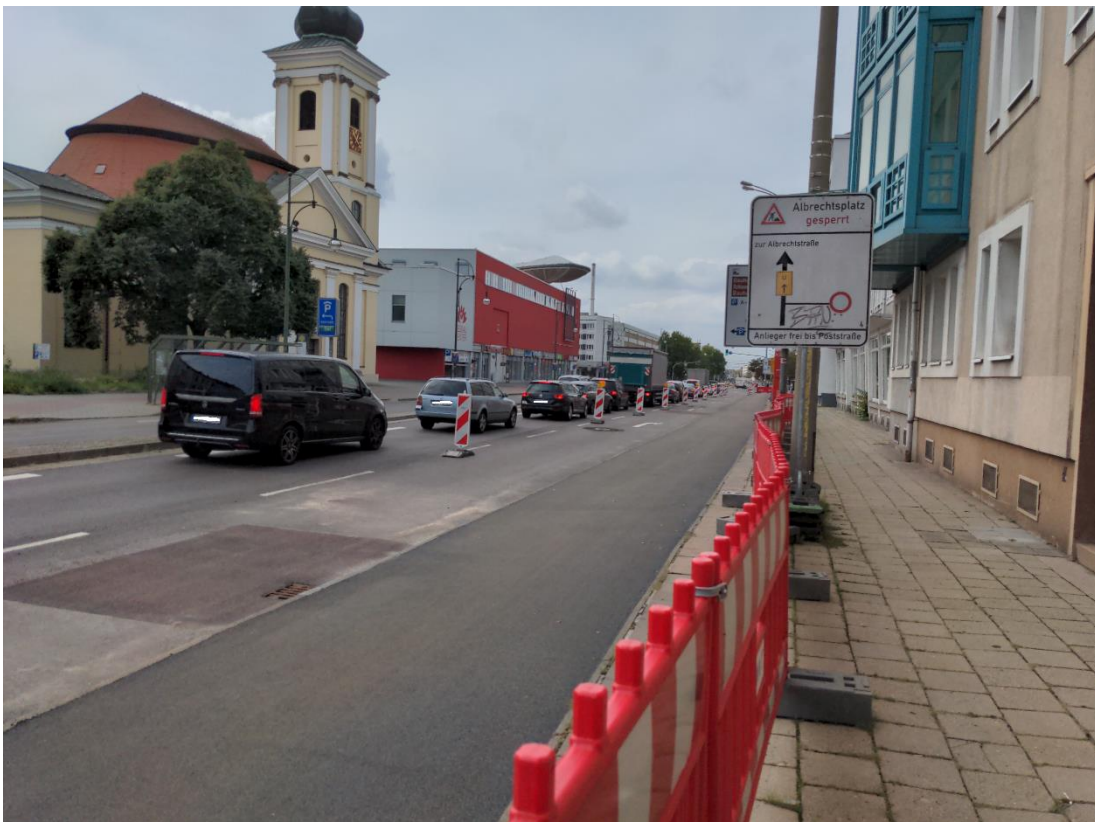
Unterhaltsmaßnahme Radweg Askanische Straße, Dessau
