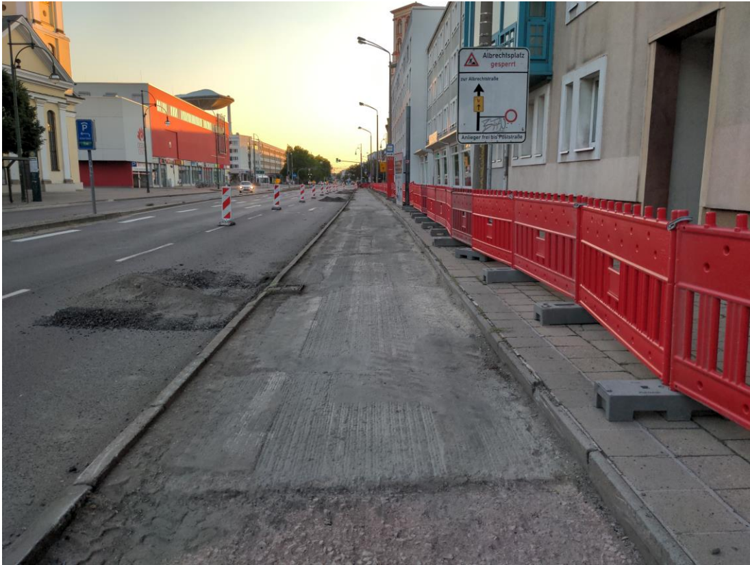
Unterhaltsmaßnahme Radweg Askanische Straße, Dessau
