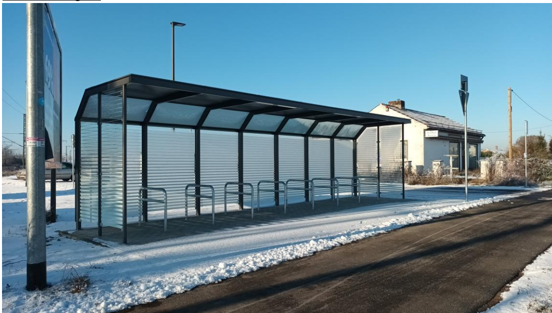
B&R-Anlage, Bahnhof Rodleben
