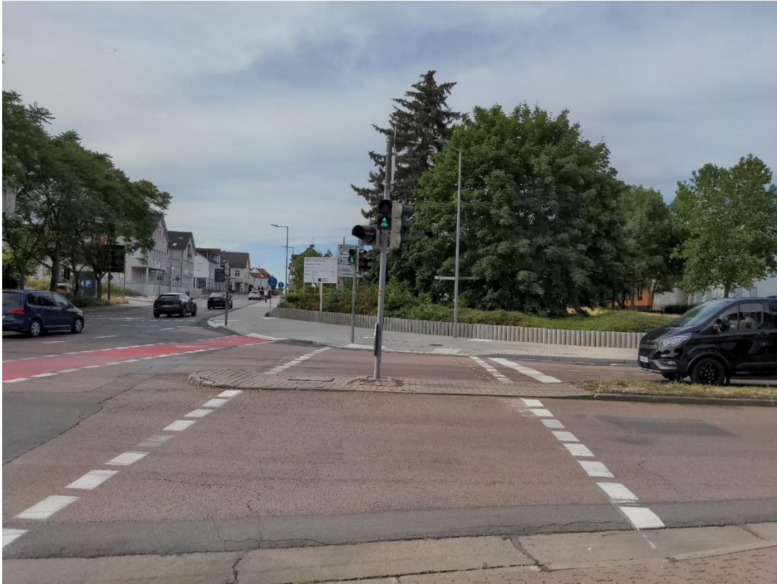
Luchplatz nach Abschluss Neubau Geh-/Radweg Luchstraße
