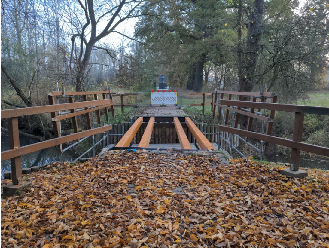
Unterhaltsmaßnahme Großmutterbrücke, Plankenlinie im Zuge Europaradweg R1
