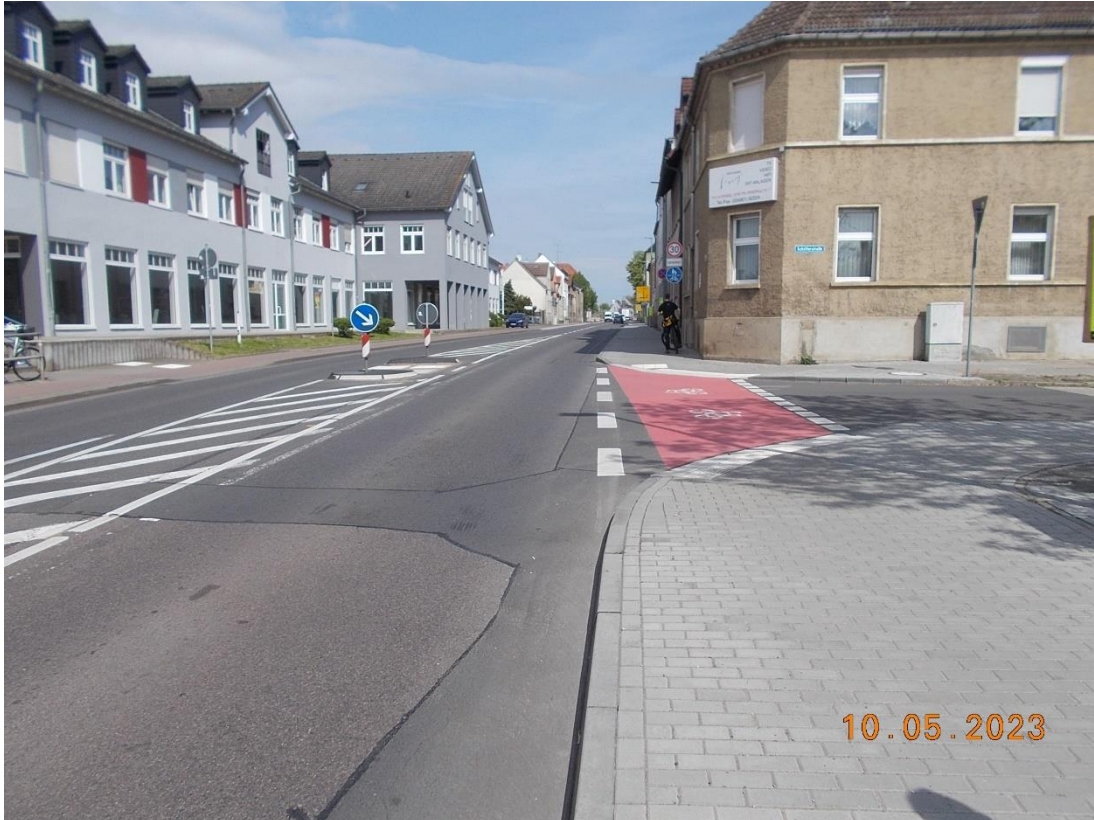
Luchstraße nach Abschluss Neubau Geh-/Radweg
