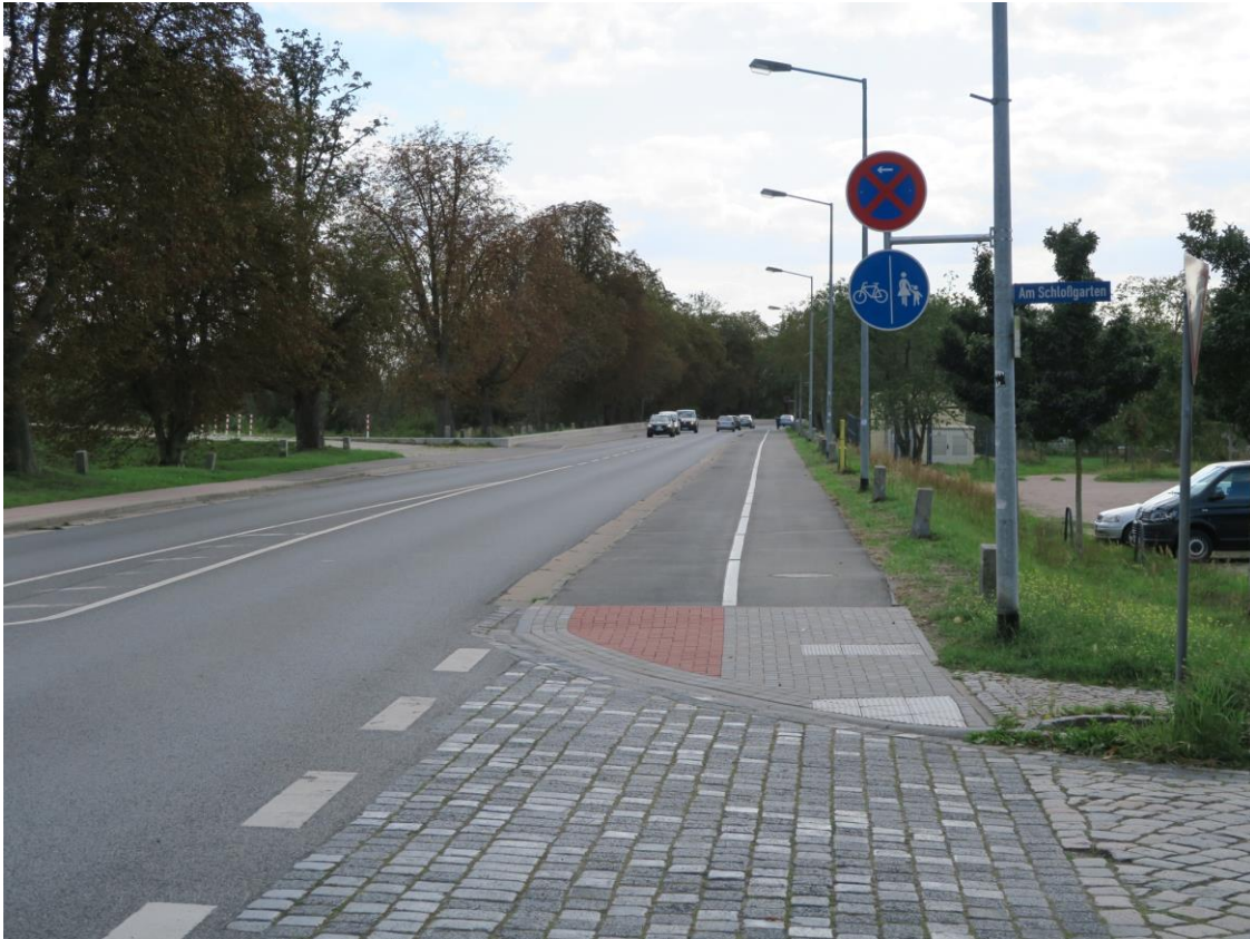
Unterhaltsmaßnahme getrennter Geh-/Radweg Südstraße Roßlau
