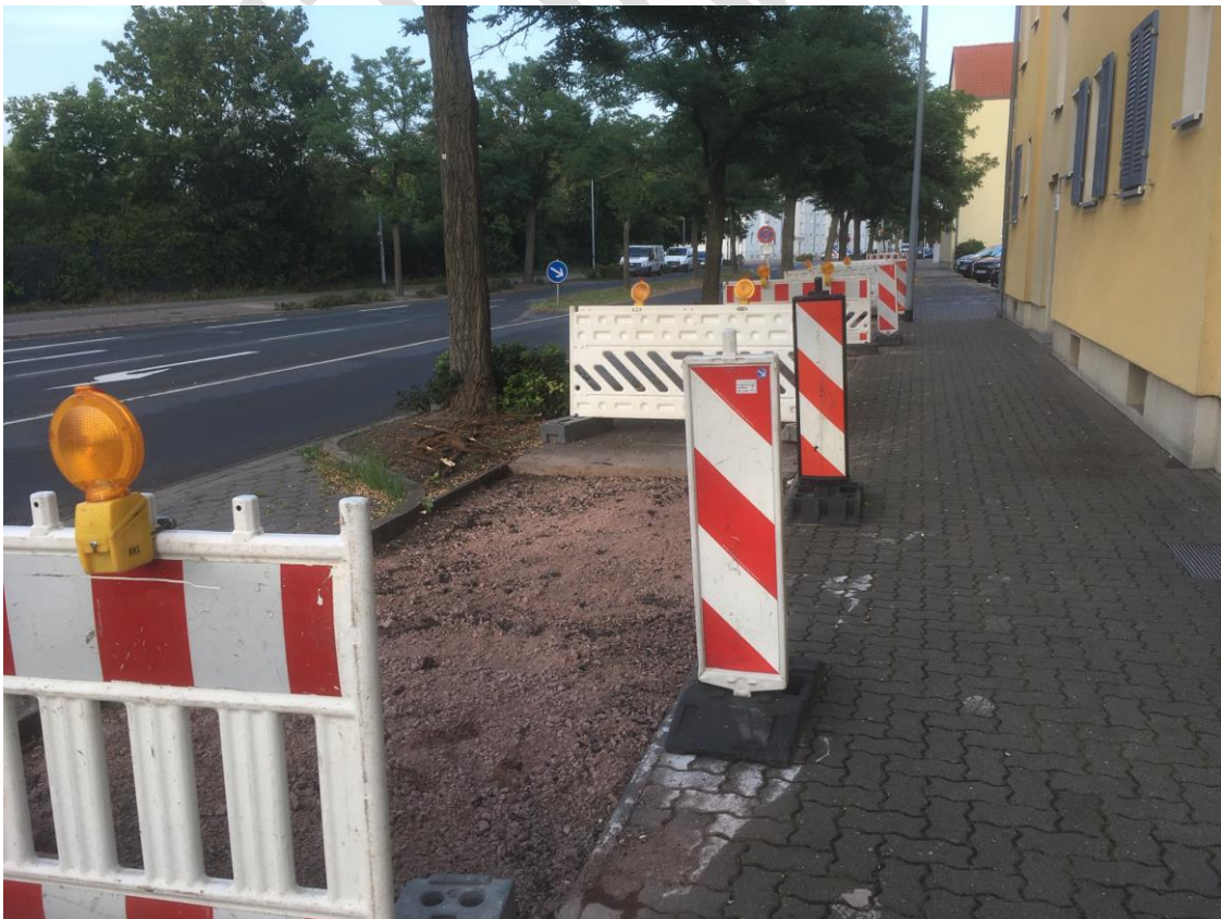
Unterhaltsmaßnahme Radweg Kabelweg
