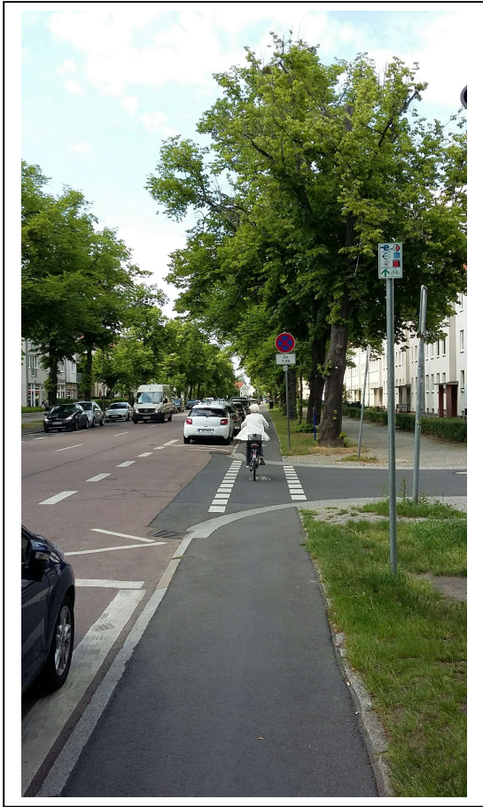
Erneuerung Radweg Gropiusallee
