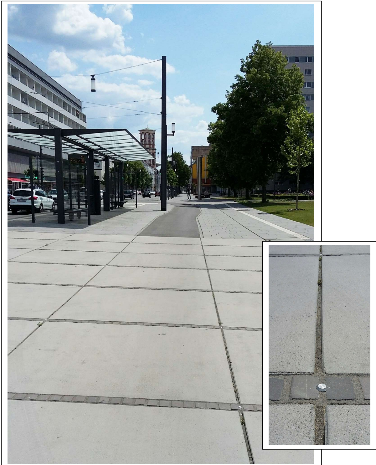
Umgestaltung Kavalierstraße, Integration des Radweges in die Fläche des Ludwig-Mies-van-der-Rohe-Platzes Detail der Noppen/ Reflektoren zur Begrenzung der Radverkehrsführung
