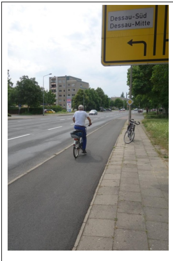
Erneuerung Oberfläche Radweg Gliwicer Straße (Unterhalt)
