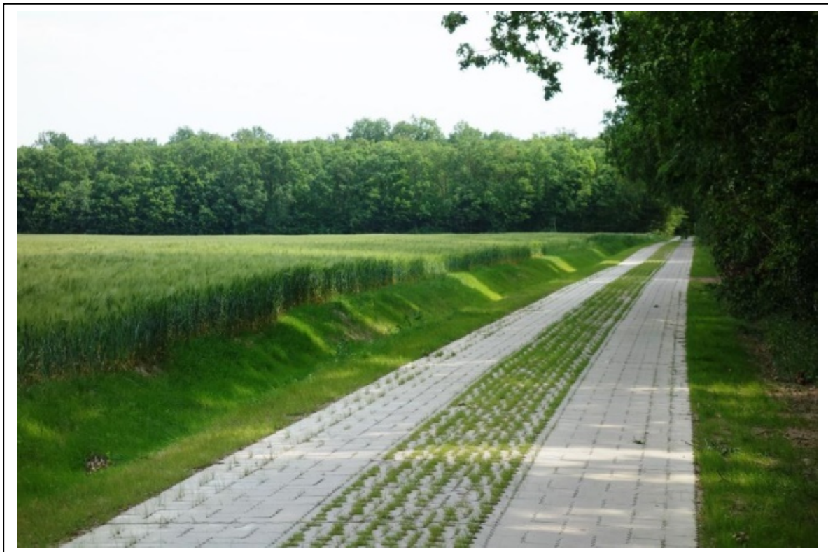
Erneuerung des Verbindungsweges Kleutsch – Sollnitz durch die Kleutscher Aue (Hochwassermaßnahme)
