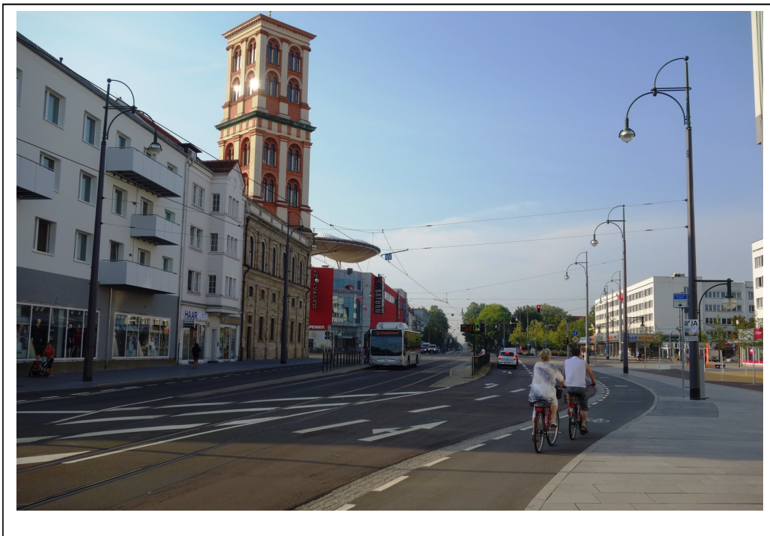
Umgestaltung Kavalierstraße, Knotenzufahrt Museum, Schutzstreifen
