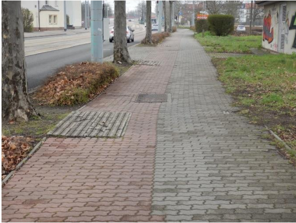
Altener Straße Dessau, hochgedrücktes Pflaster 2021 und temporärer Ersatz durch wasser- gebundene Deckschicht 2023
