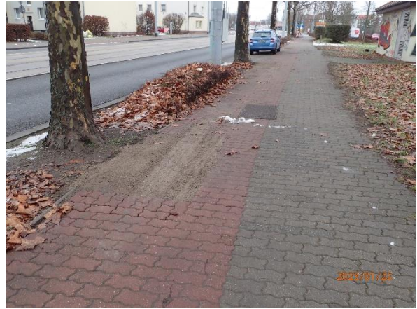
Altener Straße Dessau, hochgedrücktes Pflaster 2021 und temporärer Ersatz durch wasser- gebundene Deckschicht 2023
