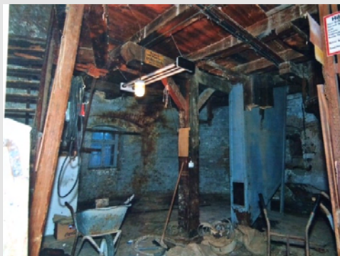
vor der Sanierung
