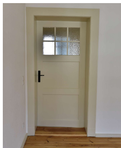
Restaurierte Wohnungsinnentür, bauzeitlicher Lichtausschnitt
