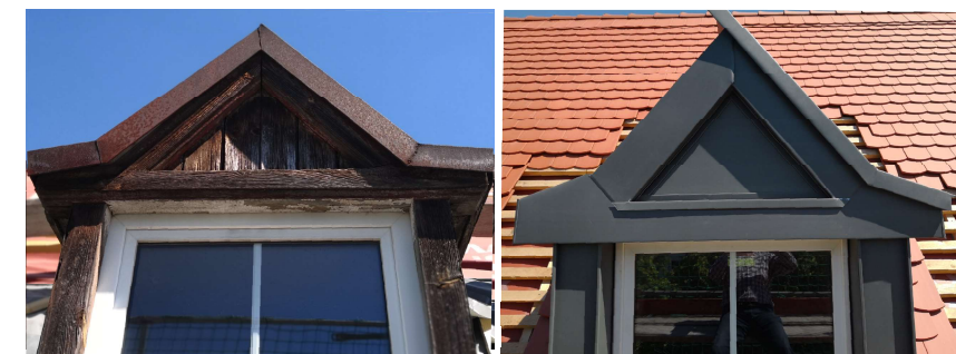
Holzgauben | Vor der Sanierung
