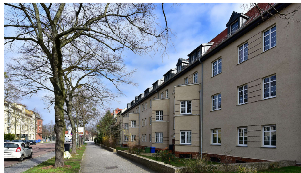
Straßenflucht | Rekonstruktion der bauzeitlichen Putzfassaden und Dachaufbauten
