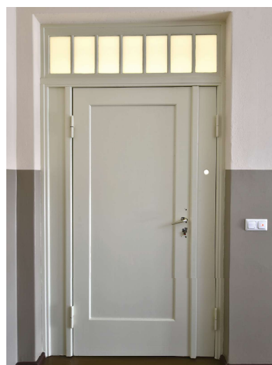
Restaurierte Wohnungseingangstür mit bauzeitlichem Lichtband
