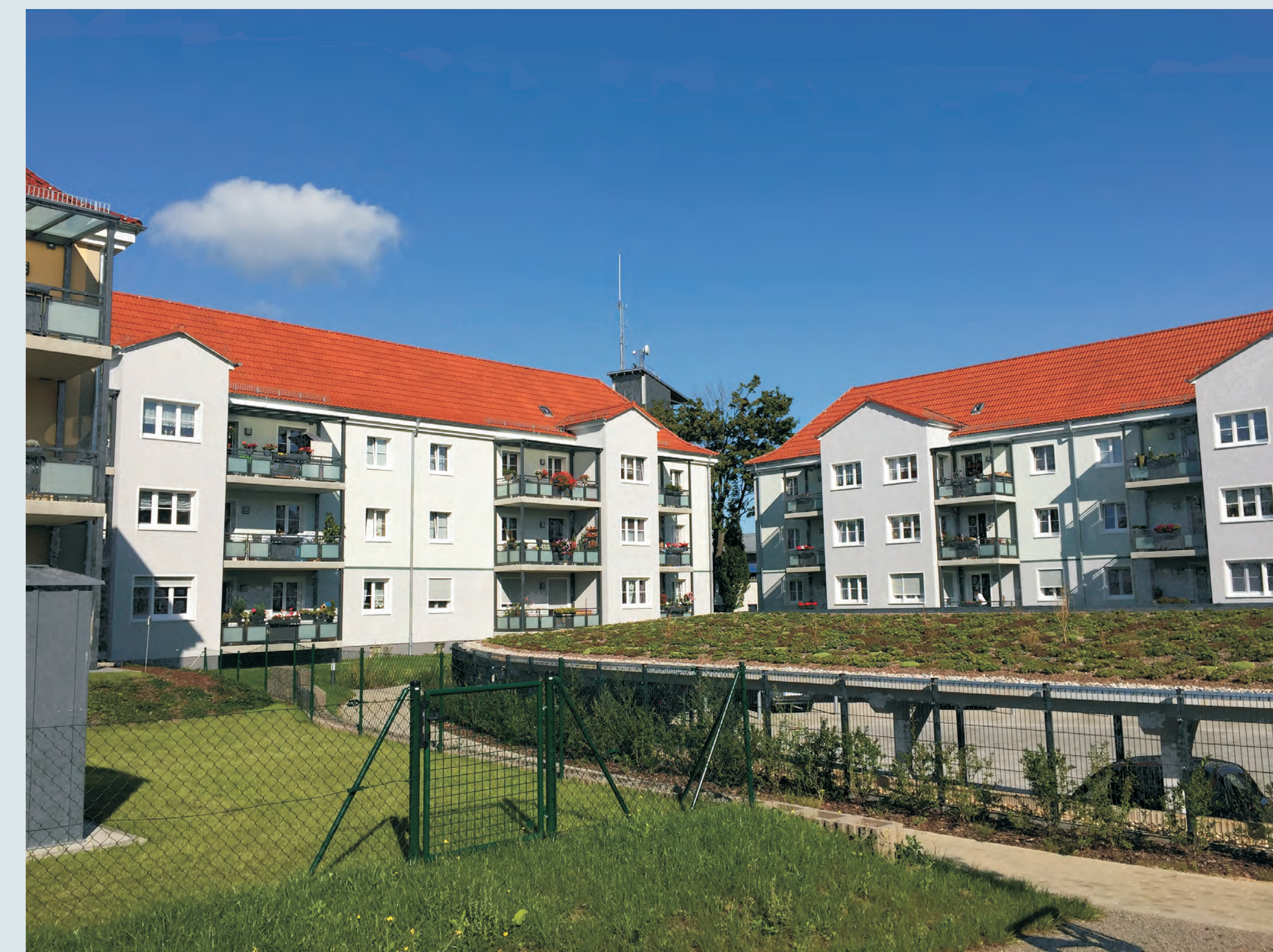
Innenhof mit Blick auf die abgesenkte Carportanlage mit Dachbegrünung
