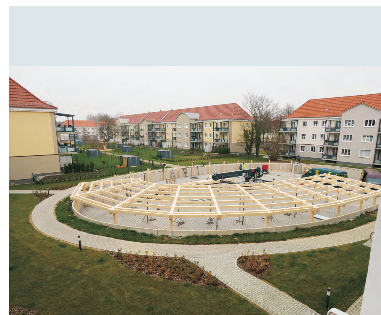
Carportanlage in der Bauphase
