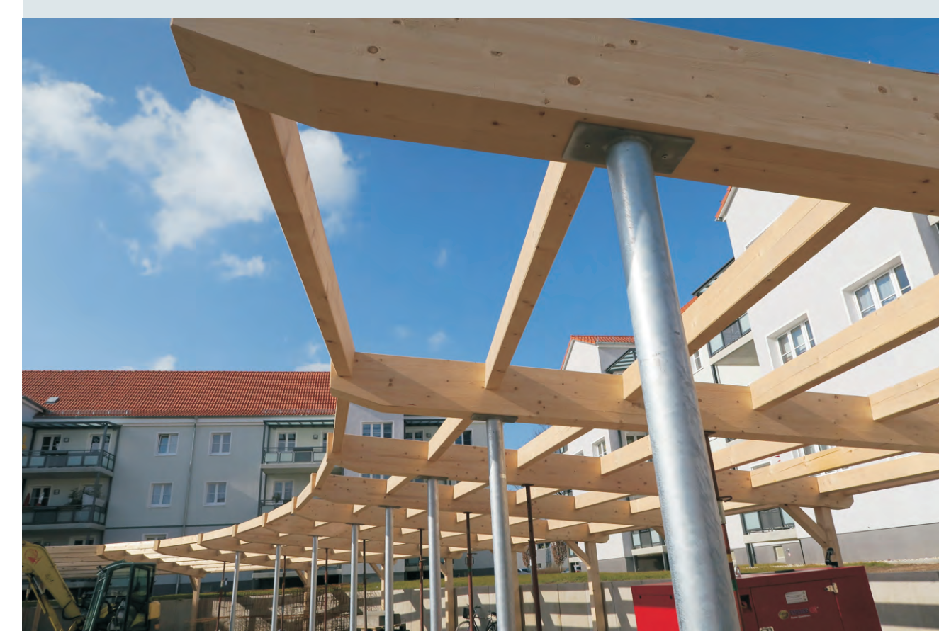
Detailansicht Carportdach in der Bauphase
