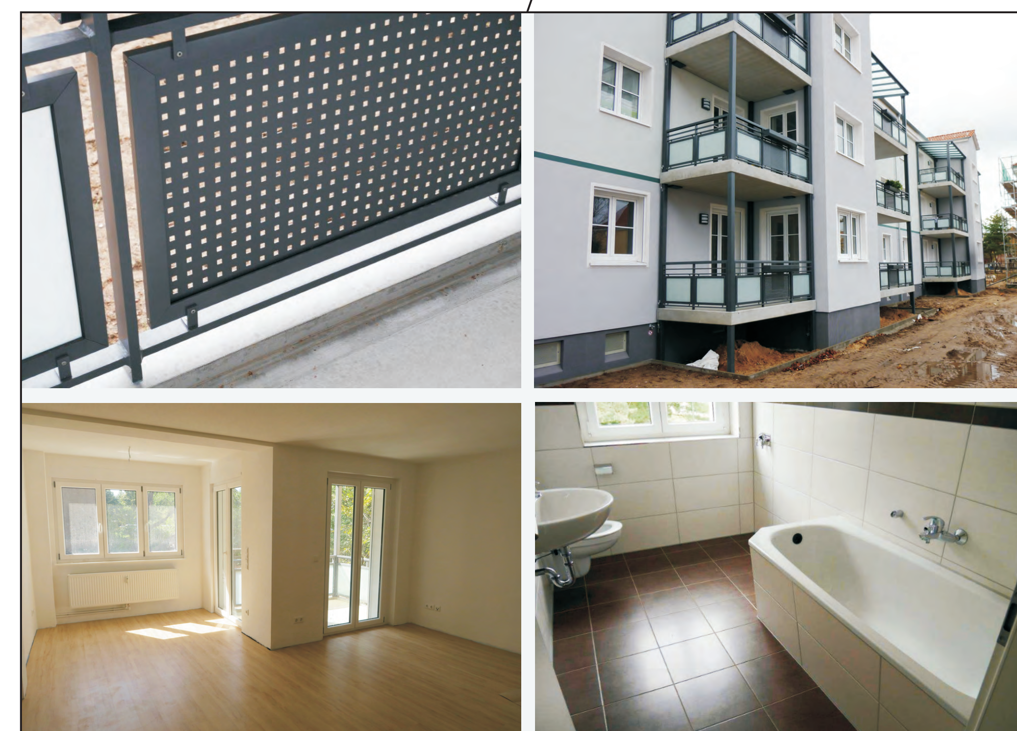
Oben links: Detailansicht Balkongeländer Unten links: Wohnzimmer mit Blick in den neuen Erker
