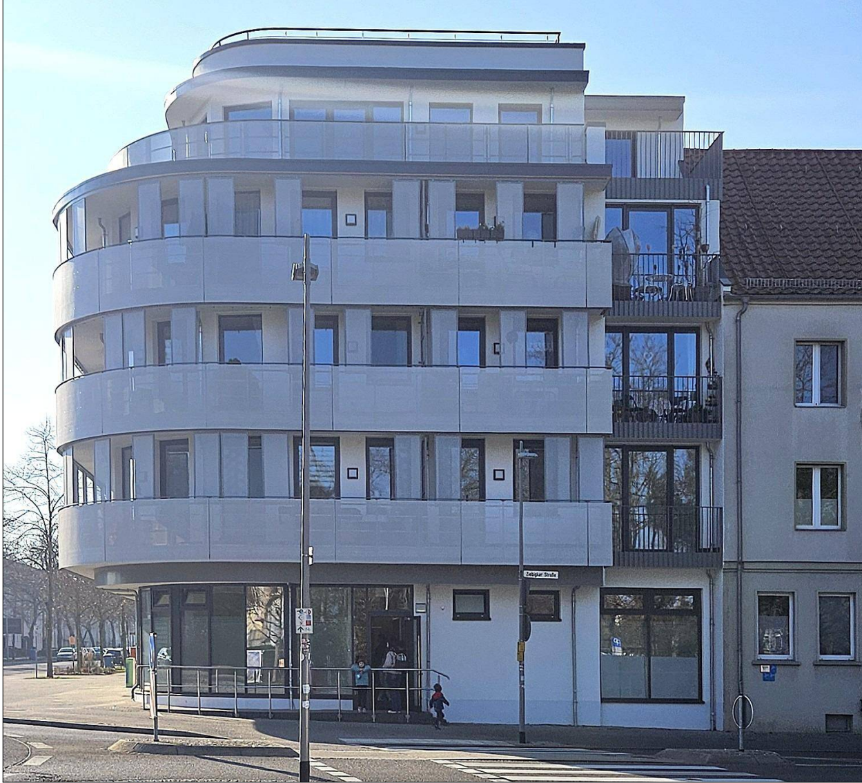
Fassade Ziebigker Straße
