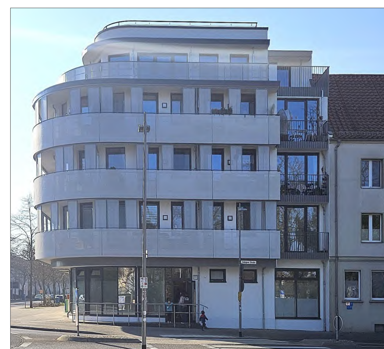
Fassade Ziebigker Straße
