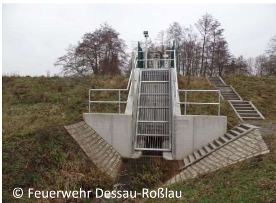
die Stauanlage Hangfichten
