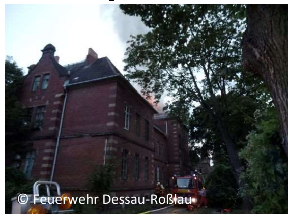
Teile des Daches stehen in Flammen.
