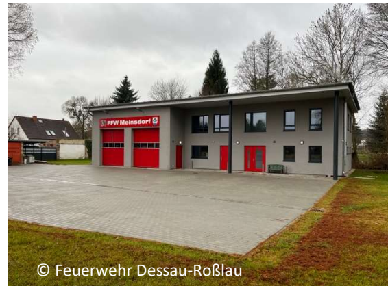
© Feuerwehr Dessau-Roßlau das neue Gerätehaus nach Fertigstellung
