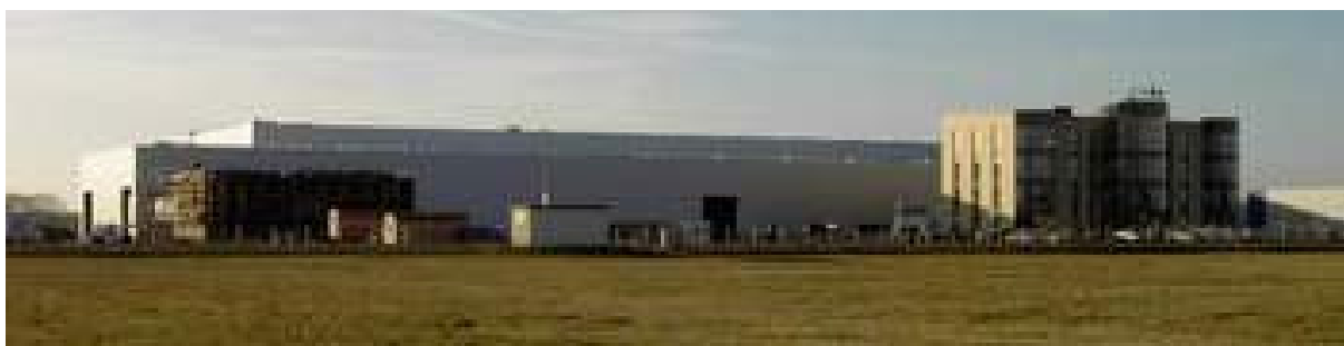
Produktions- und Lagerhalle der CEMAG Alte Landebahn
