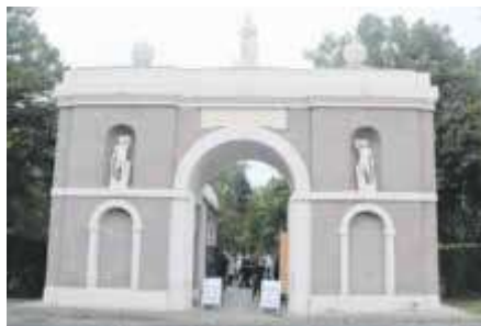
Das sanierte Erdmannsdorff-Portal. Foto: Kuhnt
