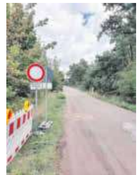
Waldrand: Instandsetzung im Spritzverfahren
