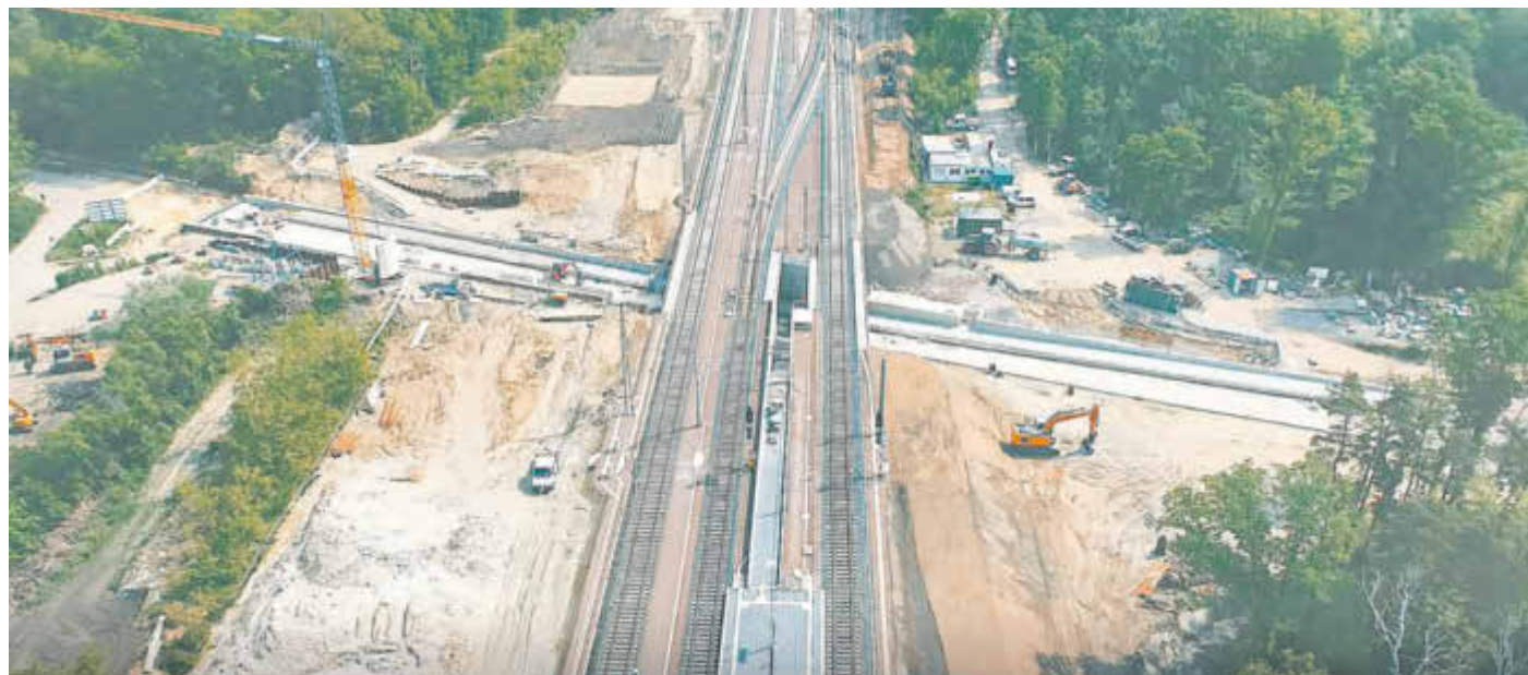
Baustelle Eisenbahnüberführung Meinsdorf Mai 2022
