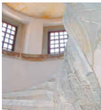
Hoch hinaus im Johannbau.
