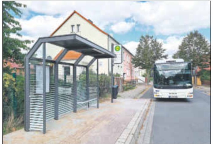
Neues Wartehäuschen Bahnhofstraße Meinsdorf.
