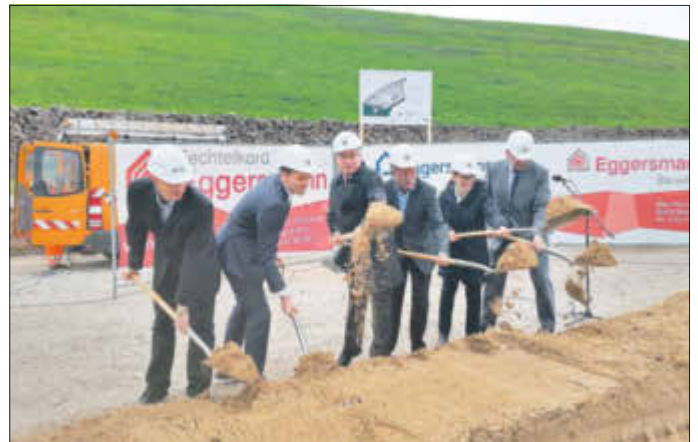
Nach dem Spatenstich legten sofort die Baufirmen los, denn bereits Ende des Jahres soll der Probetrieb laufen. Foto: Sauer
