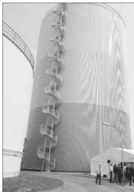
Höhe: 40 m, Durchmesser: 27 m, Gewicht: 580 t - das sind die Maße des Stahltanks auf dem Gelände des Heizkraftwerkes Dessau. Foto: Maciejewski
