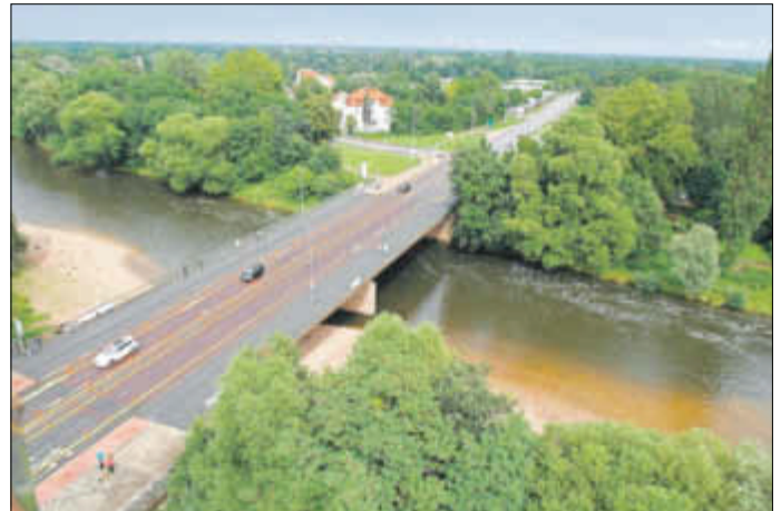
Über eine Webcam kann das Baugeschehen live verfolgt werden, auch Presseinfos und Pläne gibt es auf www.dessau-rosslau.de .
