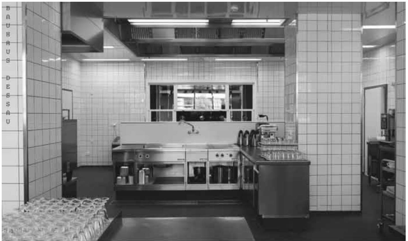
Die flache Lüftungsdecke ermöglicht wieder den Durchblick von der Mensa durch die Küche aus den Fenstern der Ostfassade. Foto: Nikolaus Brade, 2014
