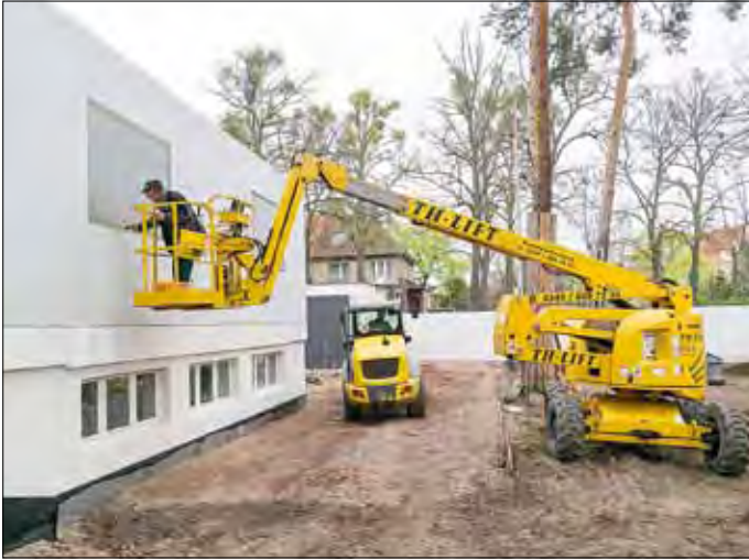
Auf der Baustelle in der Endphase (Stadtarchiv Dessau-Roßlau, Sven Hertel)
