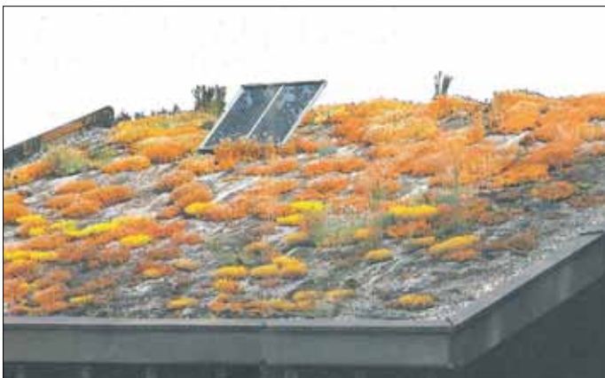
Ein begrüntes Dach in Dessau.
