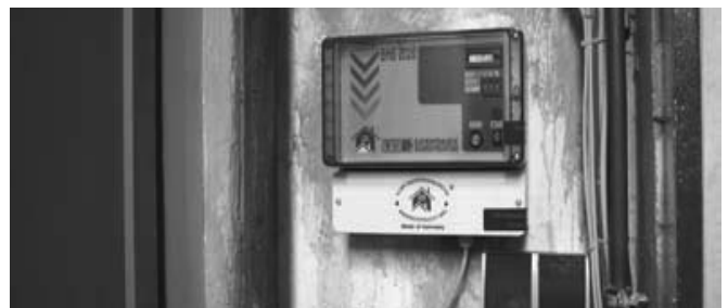
Das Wohnhaus in Wriezen erlebte so manche erfolglose Sanierungsmaßnahme. Erst nachdem im Keller ein zertifiziertes Mauerentfeuchtungsgerät der Firma BHS SCHREITER & KROLL GmbH eingebaut wurde, sind die Mauern spür- und messbar trockener geworden.
