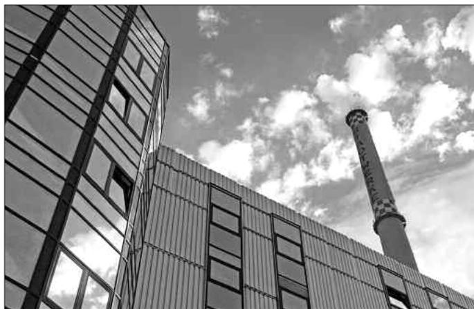
**Das Kraftwerk Dessau ist mit einer modernen Rauchgasentschwefelungsanlage ausgestattet und erzeugt mittels Kraft-Wärme-Kopplung Strom und Fernwärme. Dies bewirkt einen geringeren Verbrauch fossiler Brennstoffe und eine niedrigere Belastung unserer Umwelt als bei der entkoppelten Erzeugung der gleichen Menge Strom und Wärme.**
