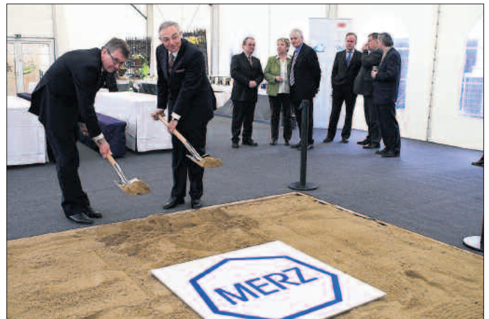
Dessaus Merz-Werkleiter Bernd Dölle und der Chef des Stammhauses in Frankfurt/Main, Bernhard Scheuble, beim Spatenstich. Foto: Hertel
