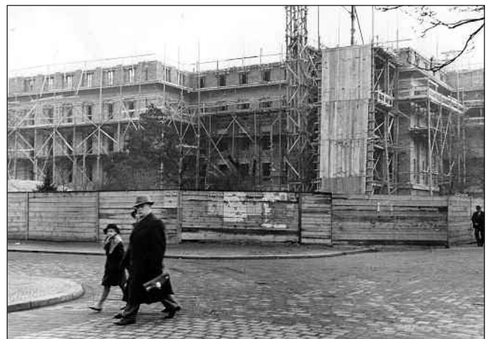
Hier war das damalige Dessauer Theater noch Baustelle.
