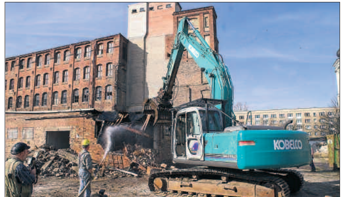
Karl Gröger und René Sittner beim Fototermin gemeinsam auf dem Bagger (oben). Im hinteren Bereich des Kaufhausgeländes wurde am selben Tag mit den Abrissarbeiten noch begonnen. Fotos: Hertel
