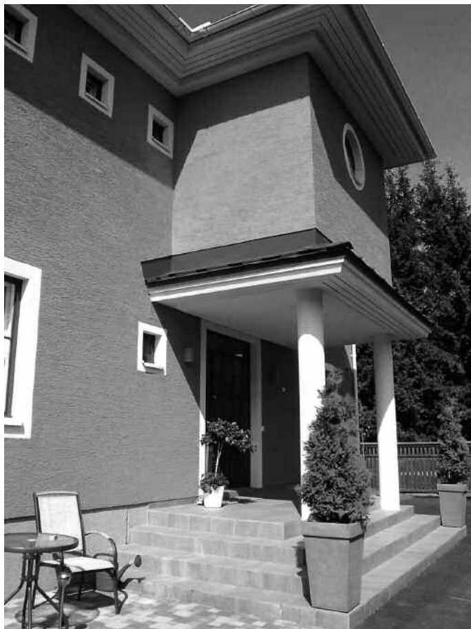
Bei der Sanierung kommt es auf die richtigen natürlichen Baustoffe an. Mineralische Putze auf Kalkbasis sorgen für gesundes Wohnklima. Foto: djd/Bundesverband Kalk
