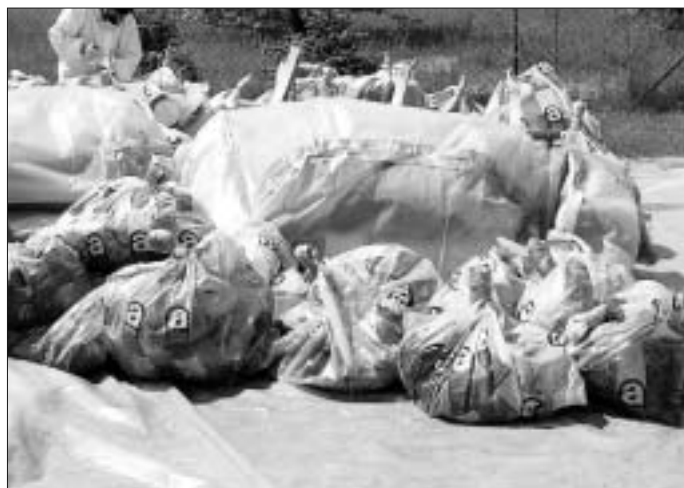
Aufwendige Beseitigung von Asbest auf einem Dessauer Grundstück im Mai 2006. Foto: Stadt Dessau
