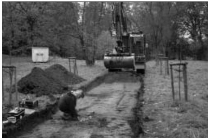
Bauarbeiten und archäologische Untersuchungen am Weinberg bei Großkühnau. Foto: H.-P. Hinze
