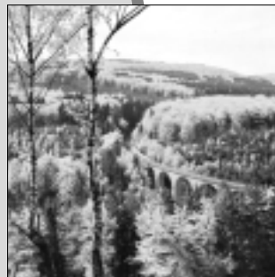
Eisenbahnviadukt zwischen Hoxel und Deuselbach
