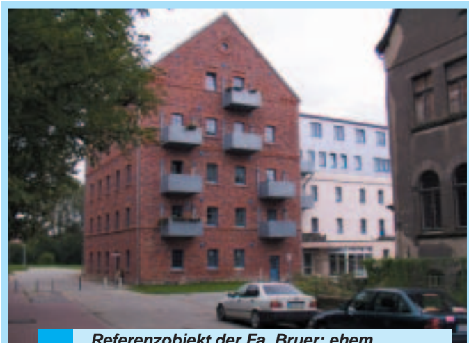
● Referenzobjekt der Fa. Bruer: ehem. Amtsmühle in Roßlau - jetzt Seniorenanlage
