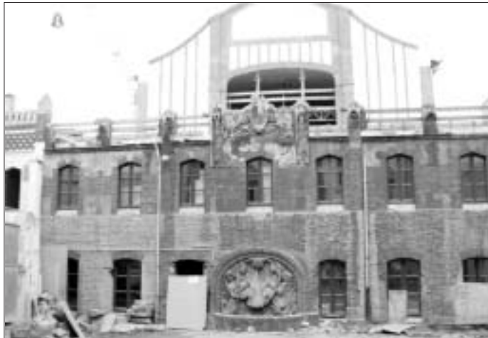
Noch wird überall gebaut.
