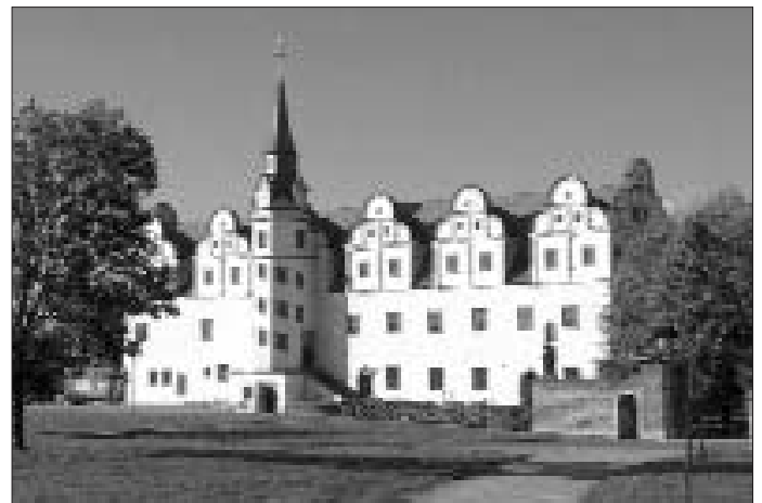
Der Johannbau ist eines der bekanntesten historischen Gebäude in Dessau. Foto: Sauer
