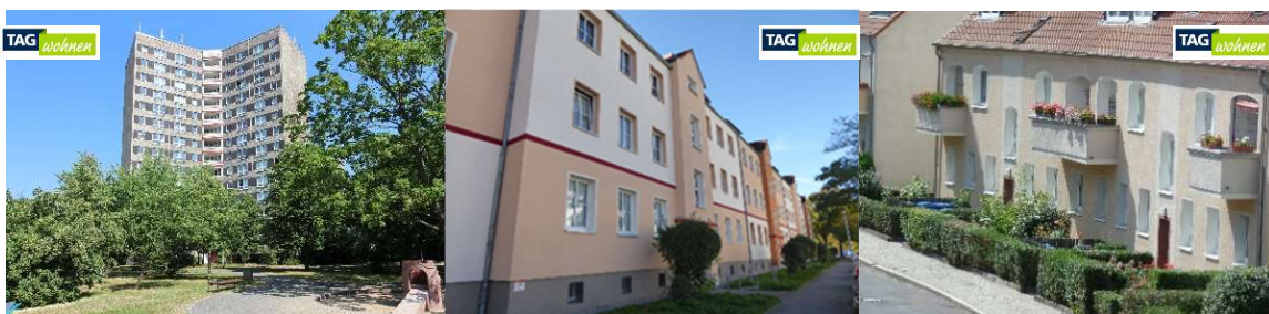
TAG Wohnen & Service GmbH ■ Willy-Lohmann-Straße 26 ■ Huttenstraße 9-13 ■ Saalestraße 60-62
