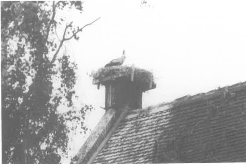
Abb. 6 Nest auf Giebelmauerwerk des heutigen Landschulheims in Mildensee; 22.7.1978
