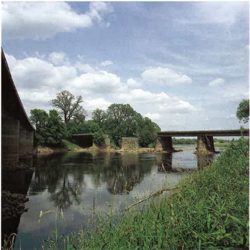
Abb. 4 Die ruinenhafte Brücke der ehemaligen Straßenverbindung zwischen Roßlau und Dessau wird von der Mehlschwalbe als Bruthabitat genutzt.
