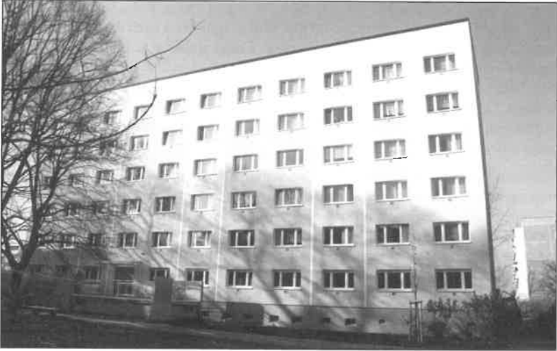
Abb. 2: Sanierter Wohnblock am Pauliplatz in Dessau-Mitte.
