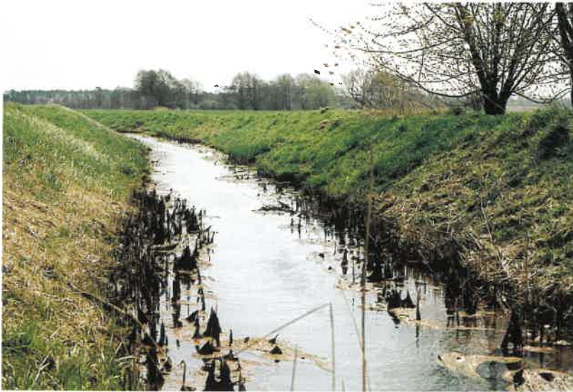
Abbildung 3 Taubeumverlegung (Kabeltaube) vor dem Ausbau, das trapezförmige Profil soll abschnittsweise naturnah umgestaltet werden. Foto: SIEGFRIED MÜLLER, Mai 1997
