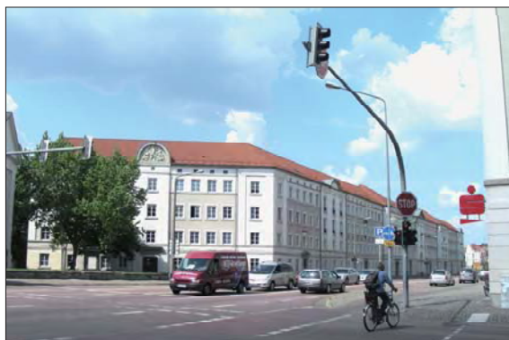
Quelle: Büro für Siedlungserneuerung
