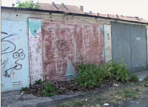
Quelle: Büro für Siedlungserneuerung
