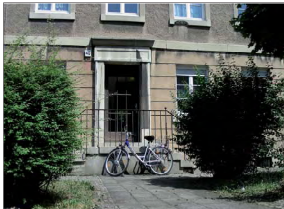
Quelle: Büro für Siedlungserneuerung
