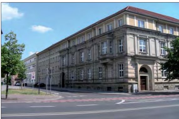
Quelle: Büro für Siedlungserneuerung
