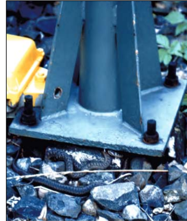
Der Metallsockel eines Bahnsignals erwärmt sich bei Sonnenschein und bietet ein hervorragendes Versteck für Schlingnattern
