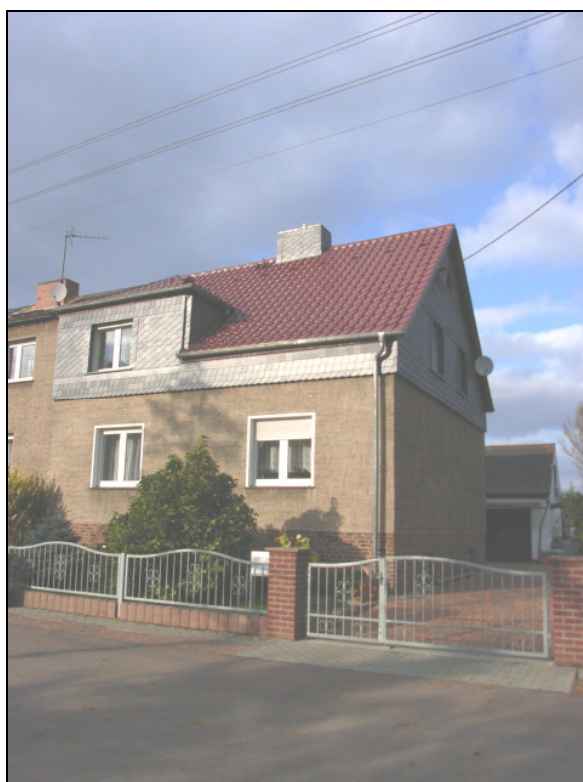
Abbildung 1 charakteristische Bebauung entlang der W.-Feuerherdt-Straße
