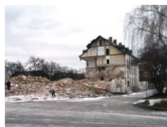
Elballee 71 und 73 Abbruchmaßnahmen Januar 2004
