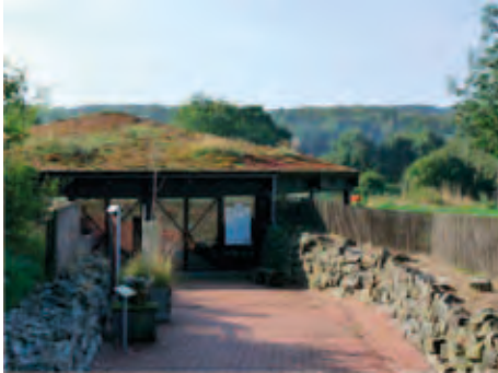
Bodenpavillion im Terra.Park
