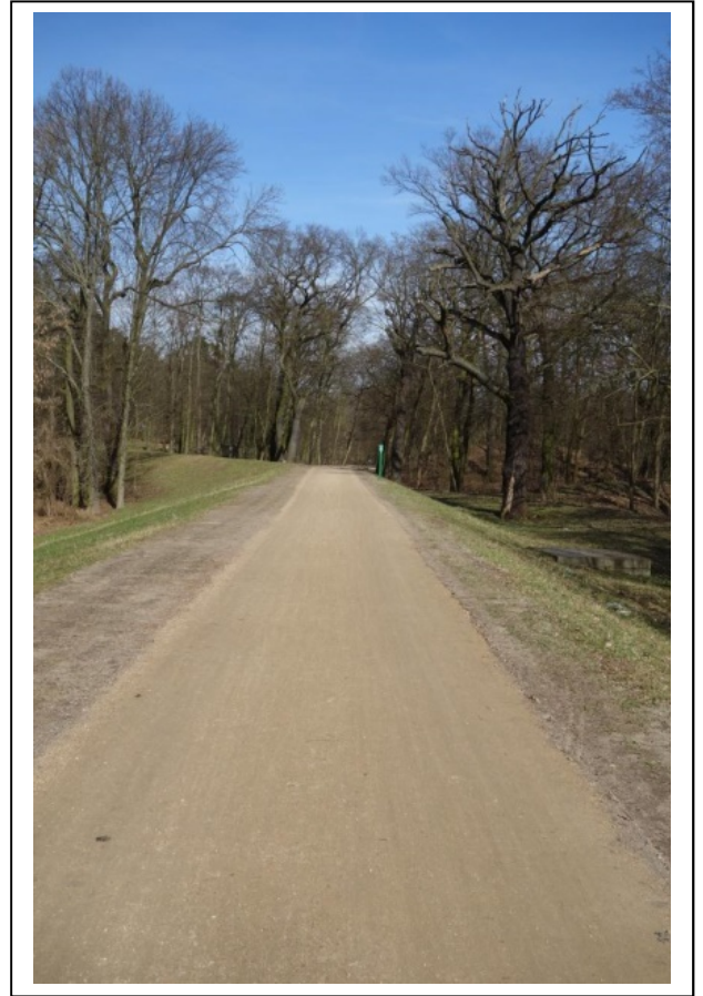
Ausbau Radroute im Becker Bruch
