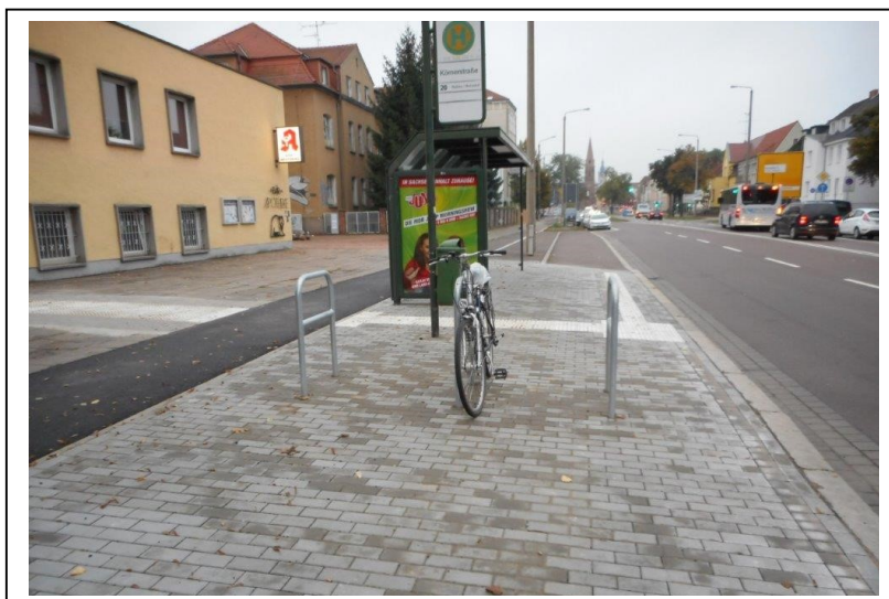
Ausbau Bushaltestelle Körnerstraße mit Fahrradbügeln
